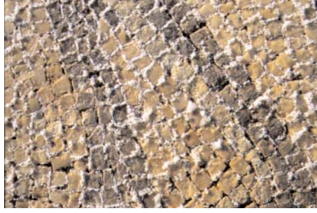
صورة ١٧: توضح ظاهرة التملح في الفسيفساء الأرضية
