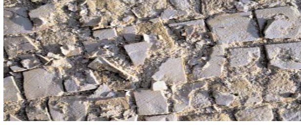
صورة ١٤: توضح ظاهرة التآكل في الفسيفساء الأرضية
