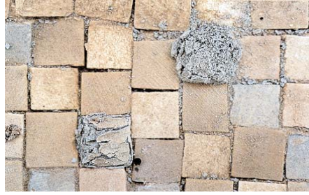
صورة ١٣: توضح ظاهرة التقشر في الفسيفساء الأرضية
